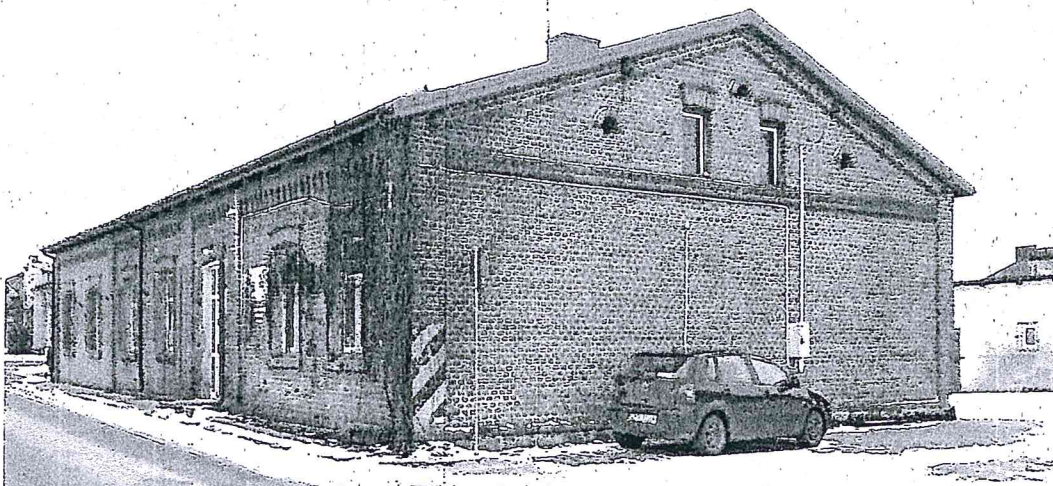
Fot. Nr 7 Elewacja wschodnia i północna
