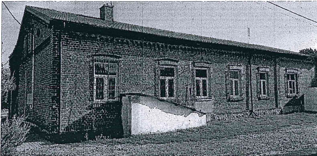
Fot. Nr 1 Elewacja zachodnia – część północna z widocznym wejściem do piwnicy
