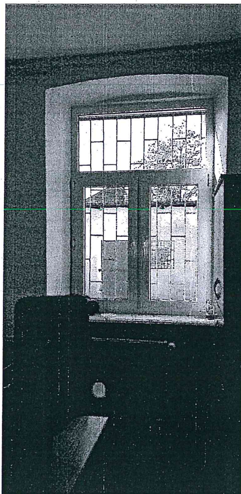
Fot. Nr 9 pomieszczenie biurowe
