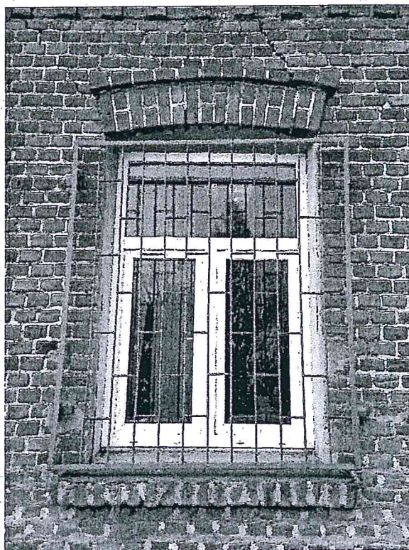
Fot. Nr 20 Detal okna na elewacji wschodniej w części północnej wysokość łuku 5 cm
