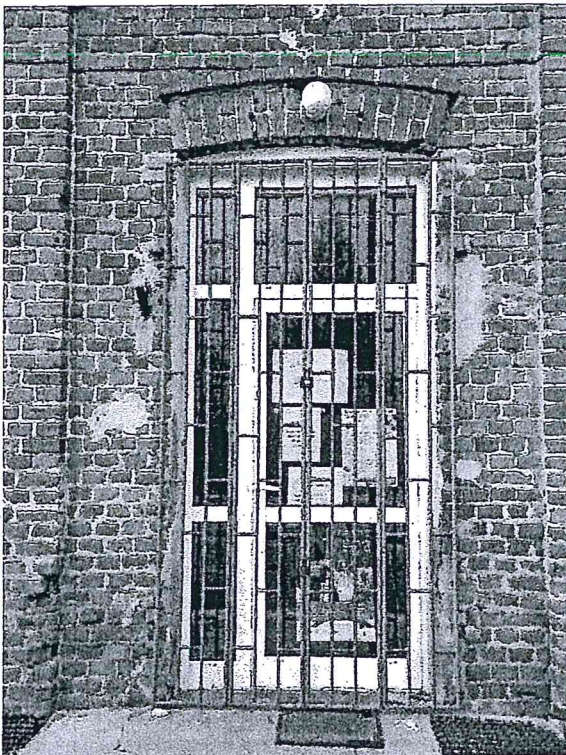
Fot. Nr 17 Detal drzwi wejściowych na elewacji wschodniej
