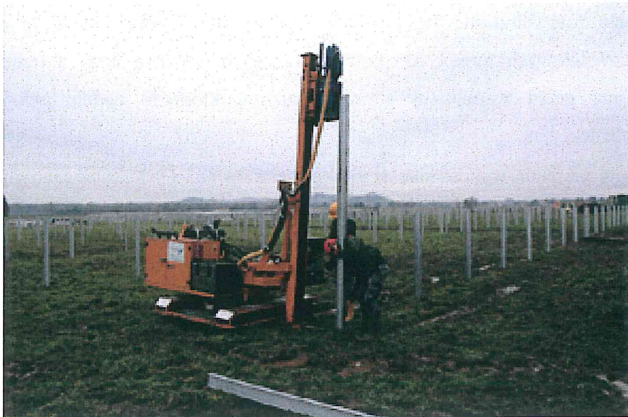
Zdjęcie 2. Montaż profili za pomocą kafara.
