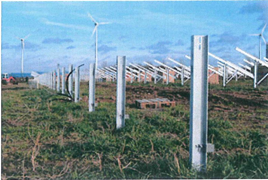
Zdjęcie 1. Profile metalowe: podstawowy element konstrukcji.
