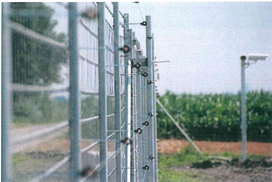
Rysunek 2. Przykładowe ogrodzenie farmy fotowoltaicznej.
