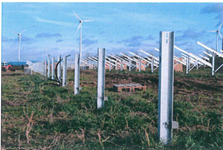
Zdjęcie 1. Profile metalowe: podstawowy element konstrukcji.
