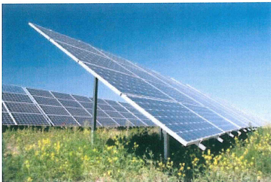
Rysunek 3. Sposób montażu paneli fotowoltaicznych na stelażach wbijanych bezpośrednio do gruntu.
