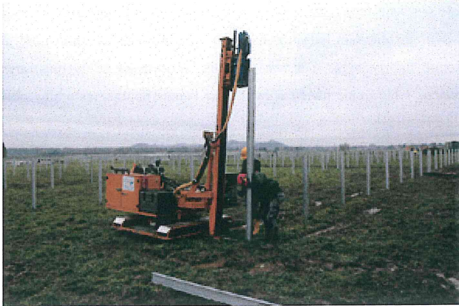
Zdjęcie 2. Montaż profili za pomocą kafara.
