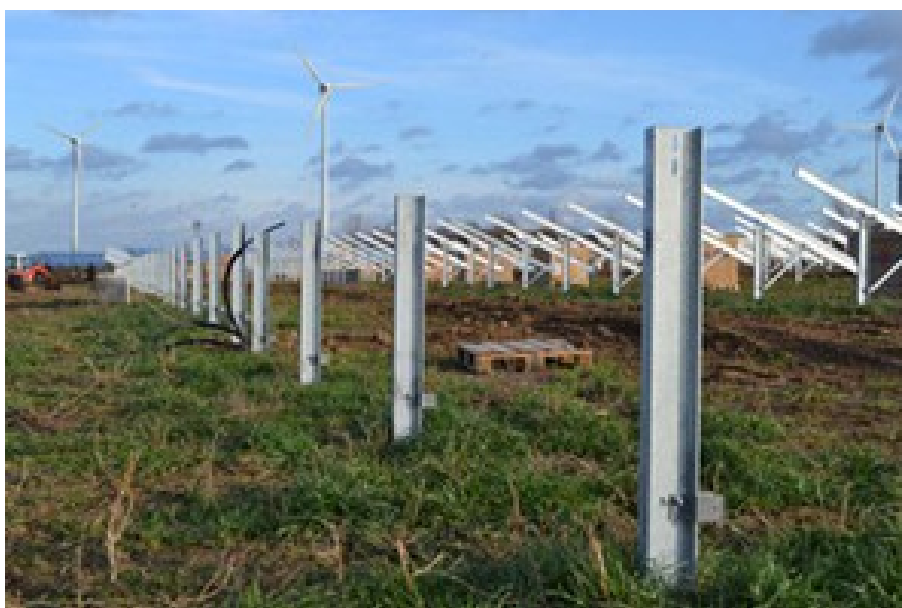
Zdjęcie 1. Profile metalowe: podstawowy element konstrukcji.
