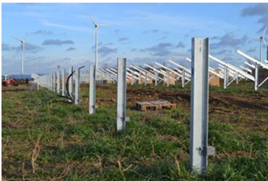
Zdjęcie 1. Profile metalowe: podstawowy element konstrukcji.
