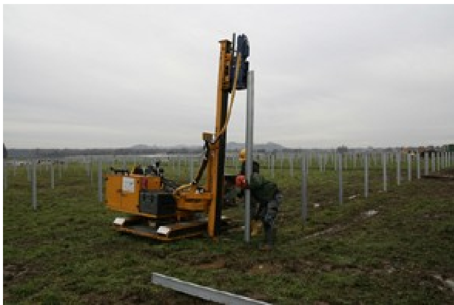
Zdjęcie 2. Montaż profili za pomocą kafara.
