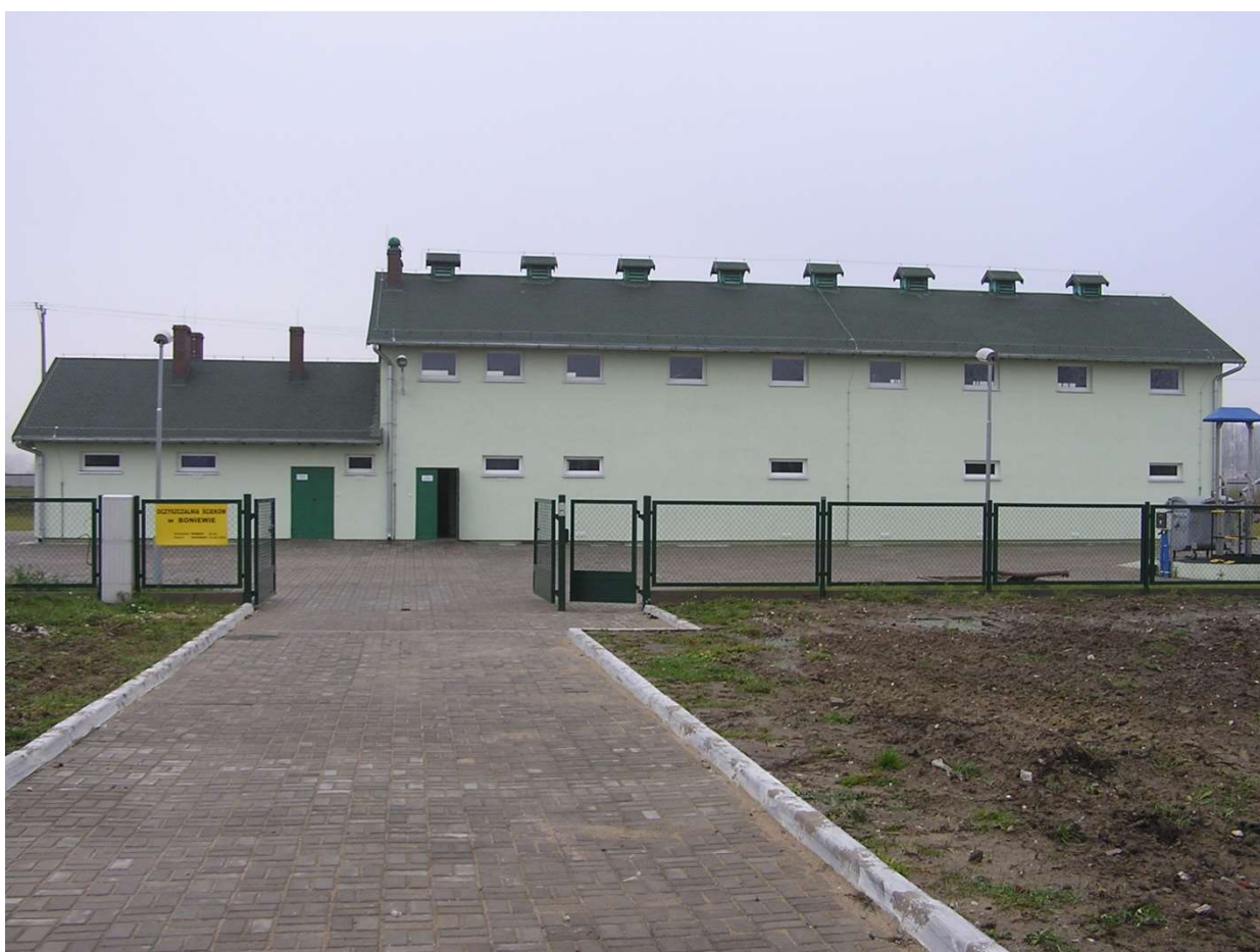
Gminna oczyszczalnia ścieków, opracowanie własne
