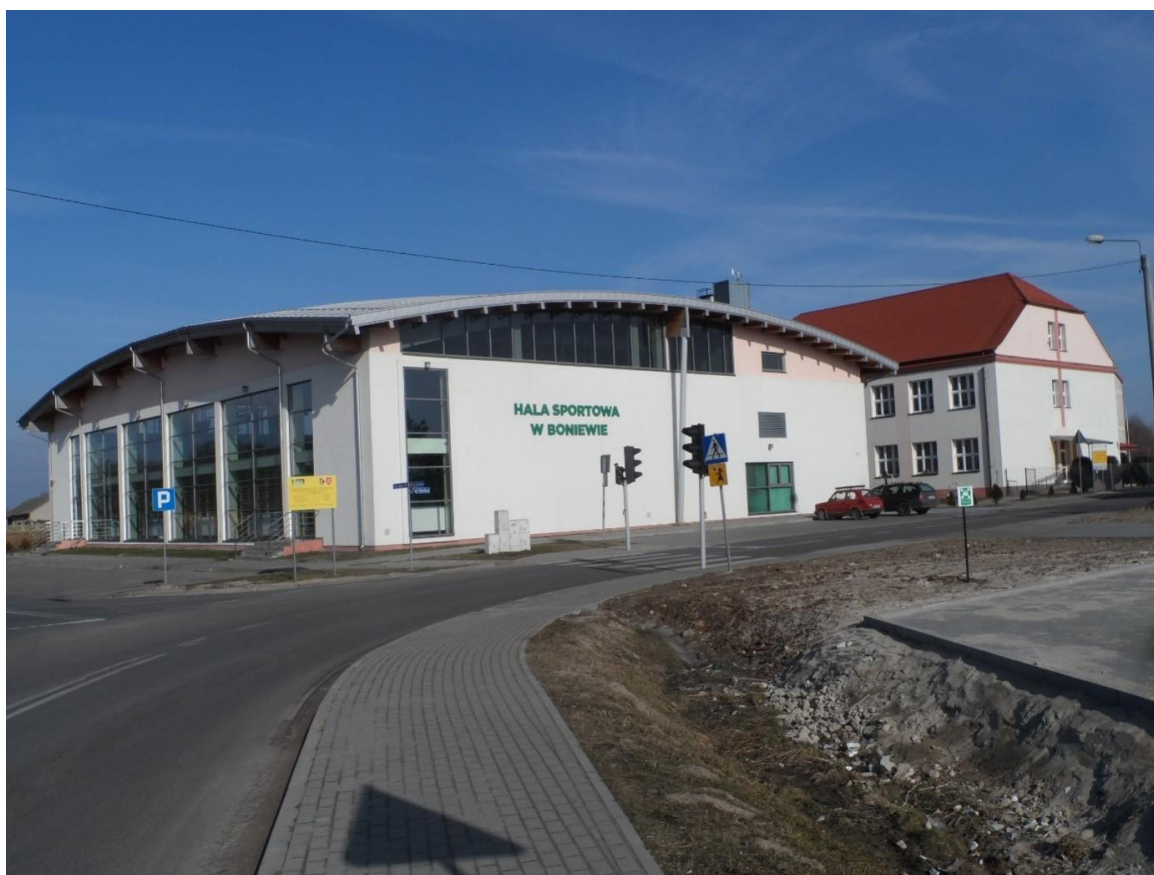
Fot: Hala Sportowa przy Zespole Szkół w Boniewie
