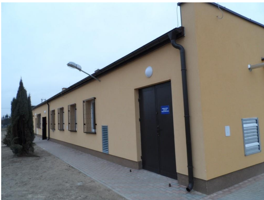
Fot: Stacja Uzdatniania Wody w Osieczy Małym
