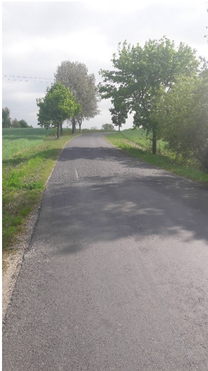
Odcinek drogi z punktowym zadrzewieniem przydrożnym
