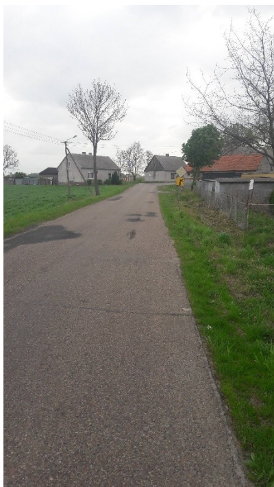
Początkowy odcinek drogi w miejscowości Lubomin
