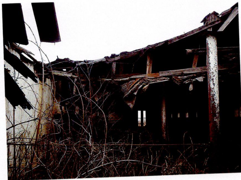
Zdjęcie nr 12 (budynek nr 1)
