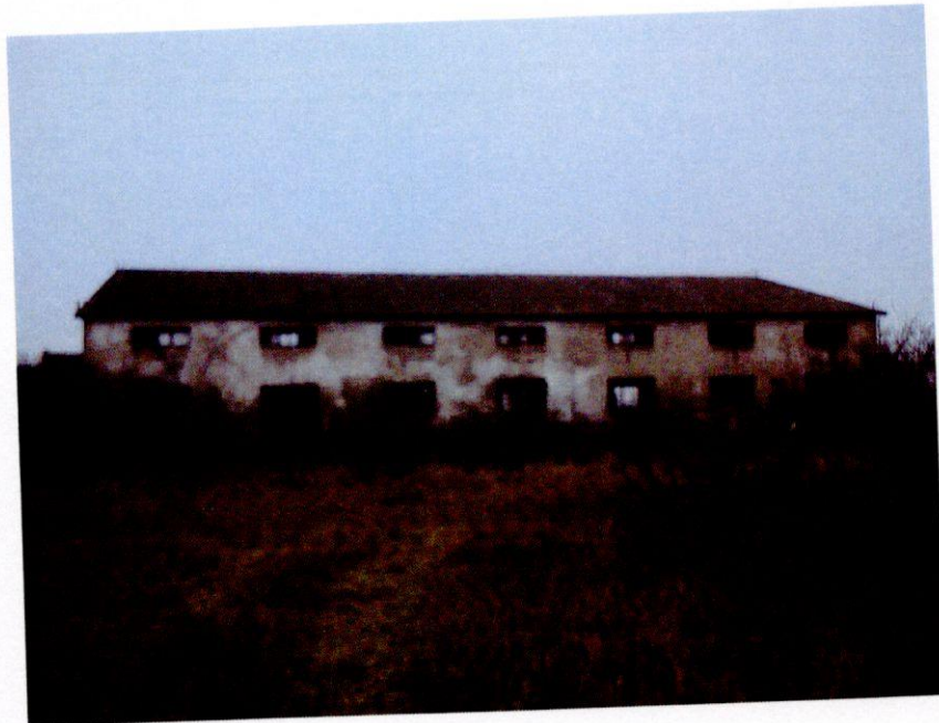
Zdjęcie nr 11 (budynek nr 3)
