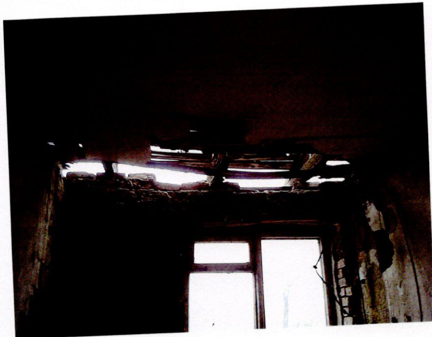
Zdjęcie nr 15 (budynek nr 1)
