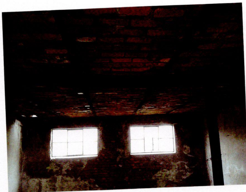
Zdjęcie nr 16 (budynek nr 3)
