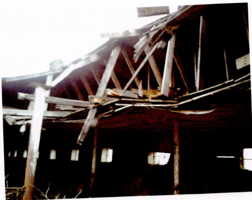
Zdjęcie nr 14 (budynek nr 1)
