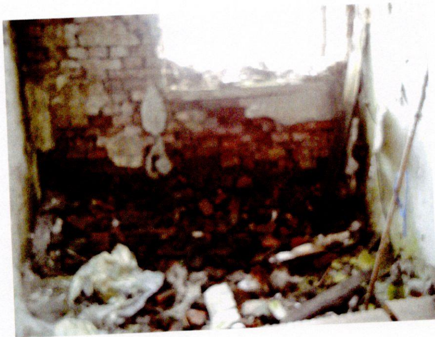
Zdjęcie nr 13 (budynek nr 1)
