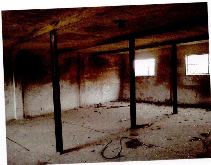
Zdjęcie nr 17 (budynek nr 3)
