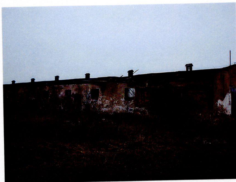
Zdjęcie nr 4 (budynek nr 1)
