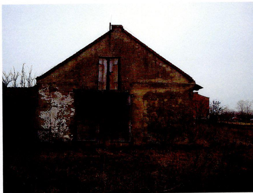
Zdjęcie nr 7 (budynek nr 2)
