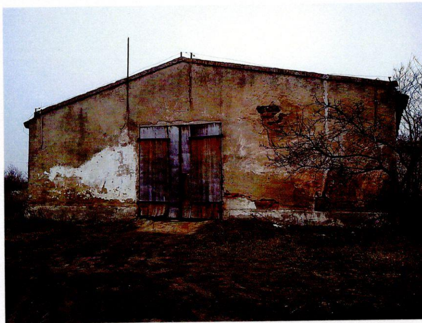
Zdjęcie nr 1 (budynek nr 1)
