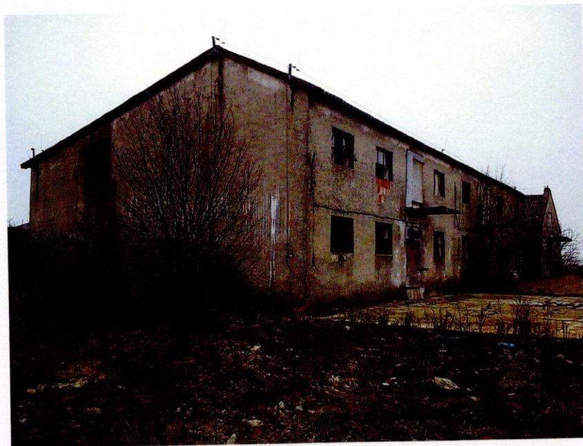
Zdjęcie nr 10 (budynek nr 3)
