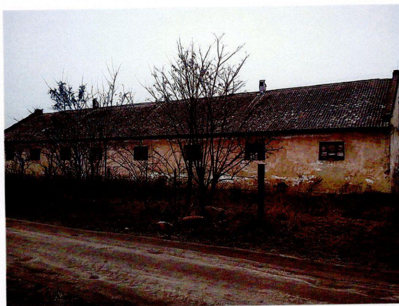
Zdjęcie nr 6 (budynek nr 2)
