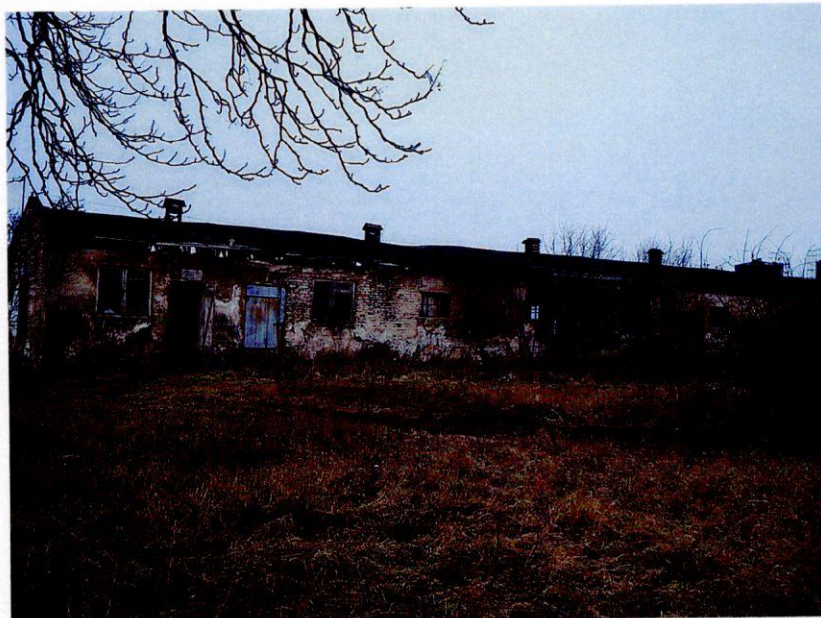
Zdjęcie nr 2 (budynek nr 1)
