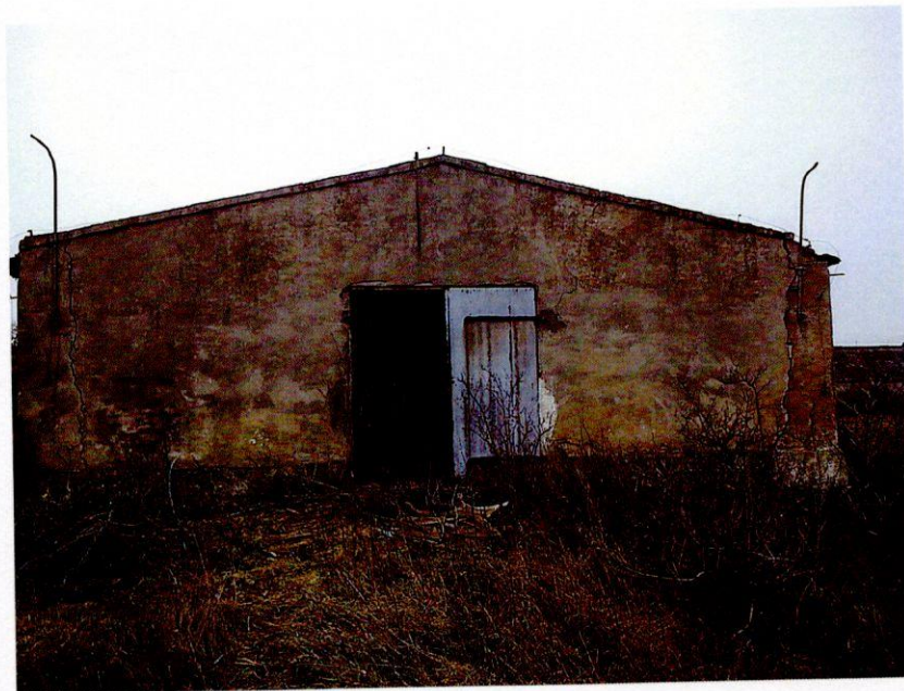
Zdjęcie nr 3 (budynek nr 1)
