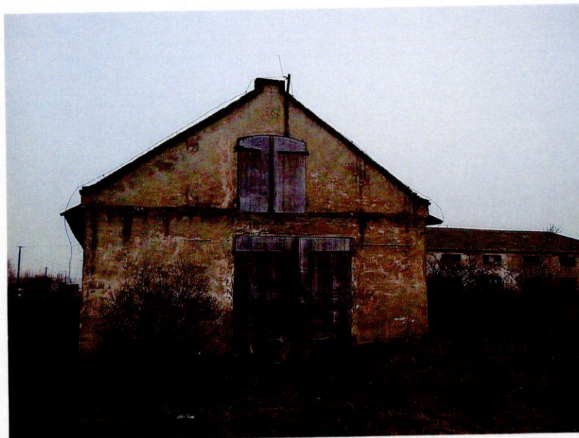
Zdjęcie nr 5 (budynek nr 2)
